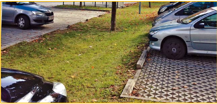
1 Rasenmulde mit Humusfilter Parkplatzentwässerung über eine Sickermulde
