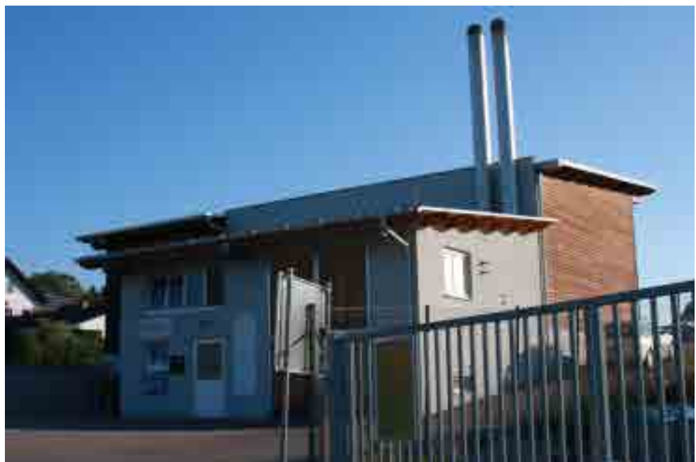
Biomasse-Nahwärmanlage Maria Laach/Jauerling; Copyright: Josef Petschko
